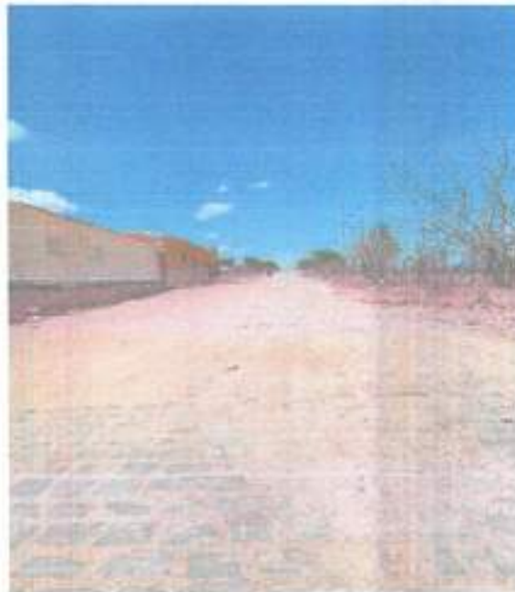
Figura 1 – Rua Abílio Faustino – Trecho 3
