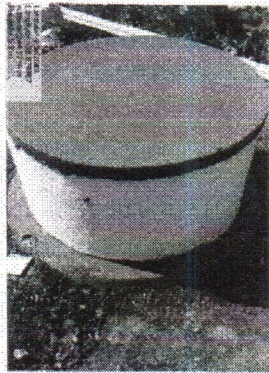
Proteção do poço
